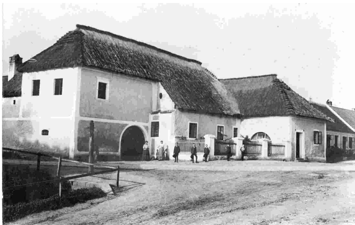
Haus Nr. 104 in der alten Bedachung
