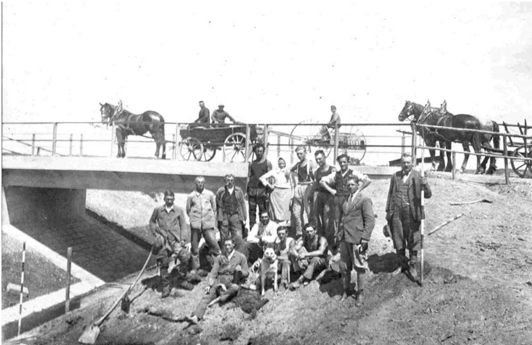
Unter der neuen Brücke ist der mit Betonplatten eingefasste Hamelbach(kanal) zu sehen. Entlang von Holzpfosten wurde aus jeder Bachseite eine Plattenreihe verlegt.
