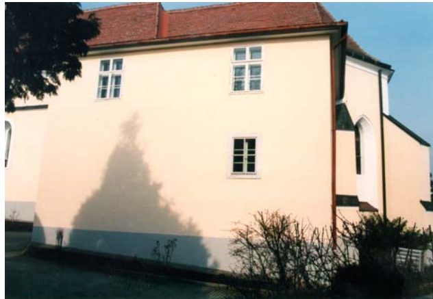
Sakristei von Südost (1999)
