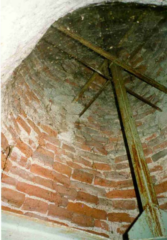
Ausmauerung der Turmhaube und Kreuzbefestigung Turmkreuz
