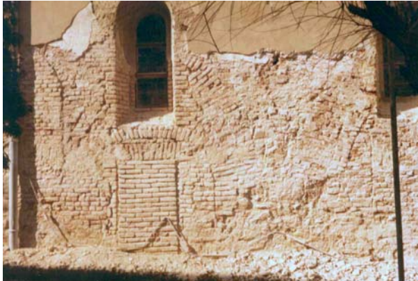
Südseite im Jahr 1977. Mehrere alte Gewölbe sind erkennbar. z.B. hinter dem Abfallrohr ein romanisches Fenster, den ausgemauerten ehemaligen Südeingang – jetzt Beichtstuhl, und darüber ein stärkeres Gewölbe, ähnlich dem Stützgewölbe der Nordseite.
