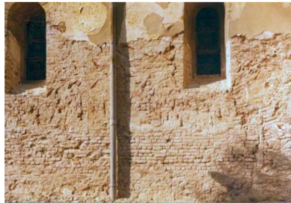
Südseite im Jahr 1977. Mehrere alte Gewölbe sind erkennbar. z.B. hinter dem Abfallrohr ein romanisches Fenster, den ausgemauerten ehemaligen Südeingang – jetzt Beichtstuhl, und darüber ein stärkeres Gewölbe, ähnlich dem Stützgewölbe der Nordseite.
