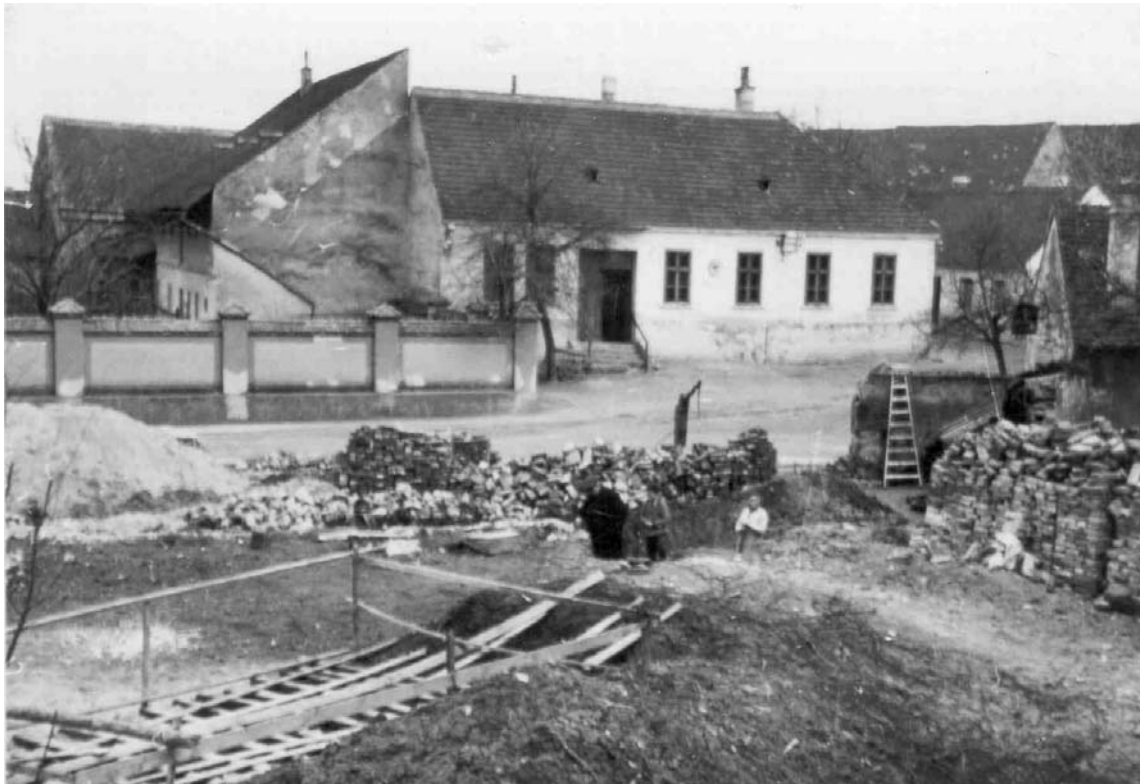
Helfer beim Bau des Fundaments für das Pfarrheim
