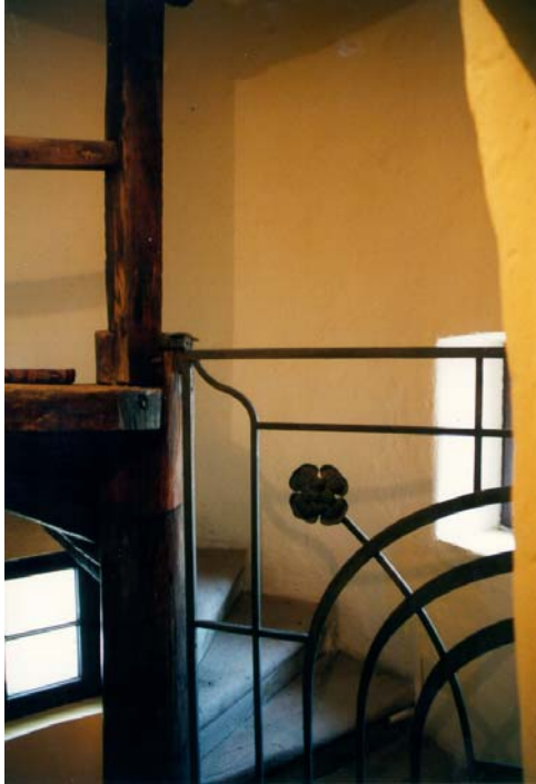
Die eichene Wendeltreppe der erst 1821 angebauten Kirchturmstiege ist im Bereich des Choreingangs durch ein schmiedeeisernes Türl abgetrennt.
