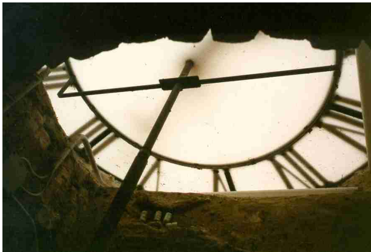
Rechts im Bild die Leuchtstoffröhre zur Innenbeleuchtung der Ziffernblätter
