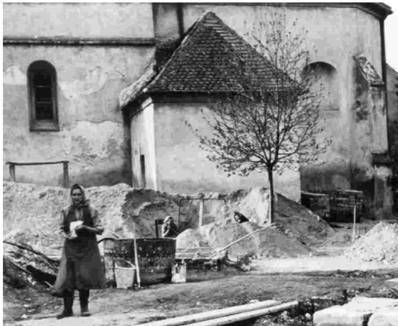
Die 1718 erbaute Sakristei. Aufnahme beim Pfarrheimbau 1952
