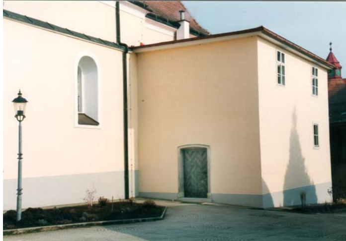
Sakristei von Südwest 1999
