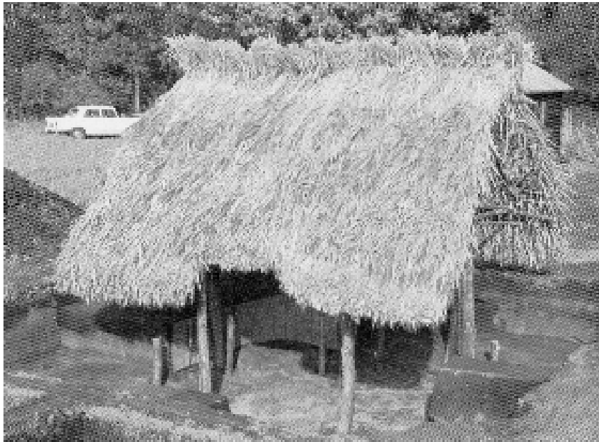
Rekonstruierte und später experimentell abgebrannte Sechspfostenhütte
